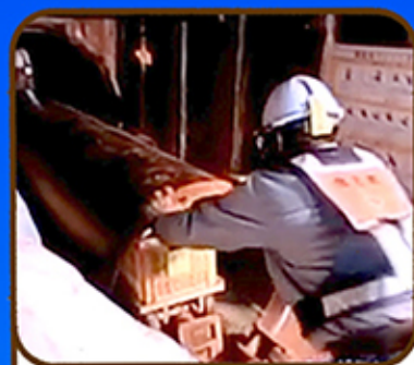
新しい水道管を 入れるところ
