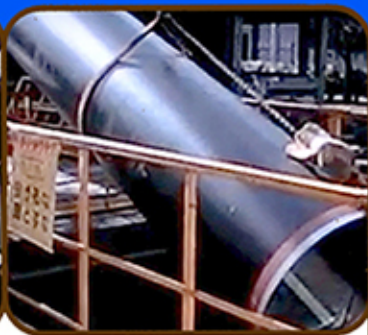
新しい水道管を 地面の中に 入れるところ
